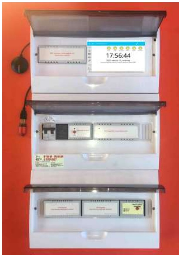
93. kép A kijelzőt célszerű szemmagasságban elhelyezni. Ha szükséges, akkor a vezérlő és vezérelt készülék dobozai egymással megcserélhetőek a gyártás során.
