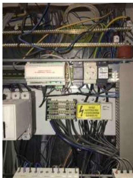
94. kép Olyan kialakítás is összeépíthető, ahol a kijelző és az egyéb modulok nem egymás mellé kerülnek
